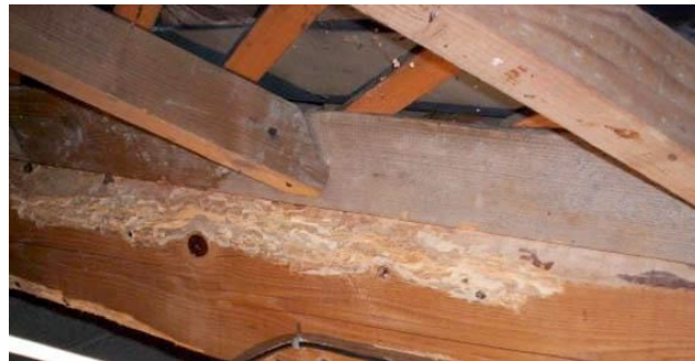
Exemples de dégradations sur des charpentes bois
