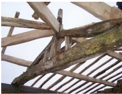
Exemples de dégradations sur des charpentes bois
